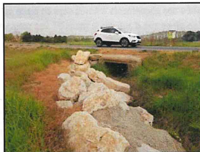
Illustrations de l'ouvrage hydraulique actuellement en place au niveau de la RD189 (source : MEDIA, décembre 2019)
